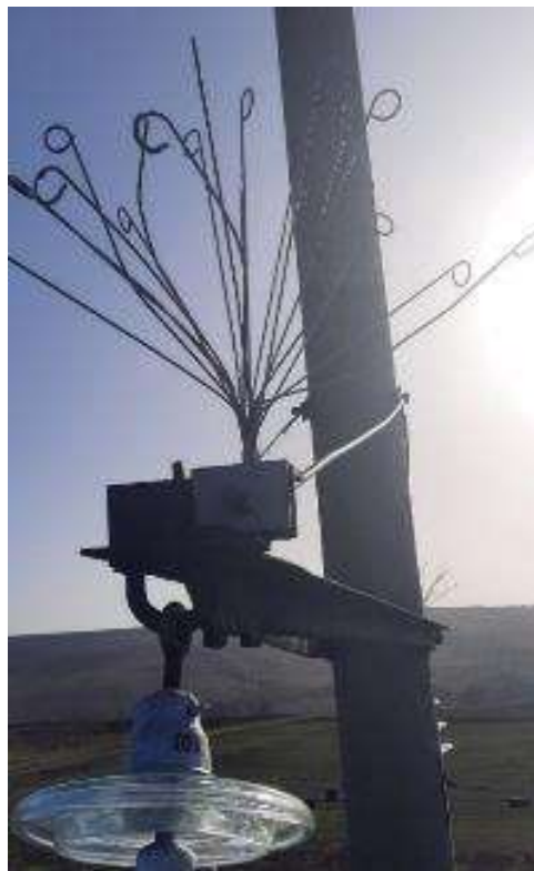
Figura 5. Dispozitive antipăsări LEA 35-110 kV
