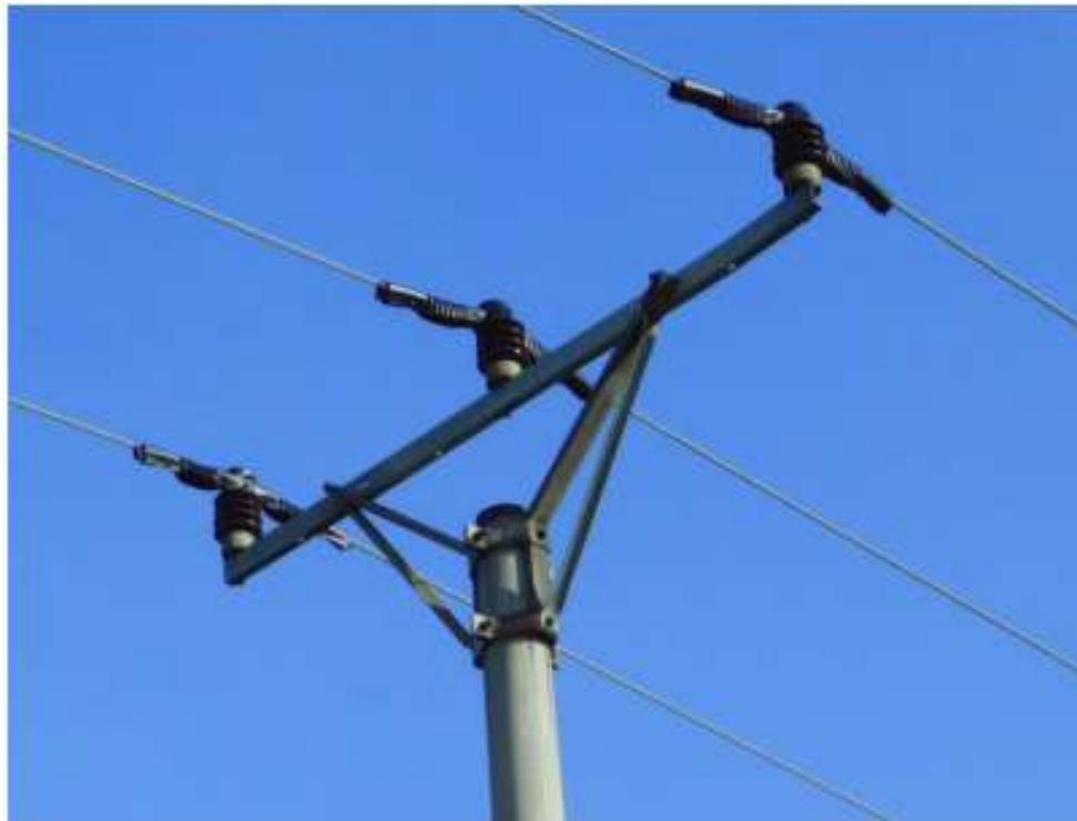
Figura 2. Tecile electroizolante pentru LEA 6-10 kV
